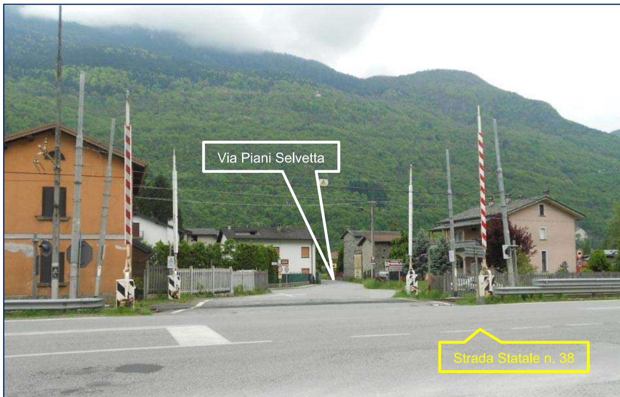
Figura 3.1 – Passaggio a livello al km 26+055 da sopprimere
